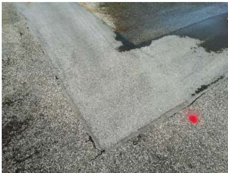
Abbildung 3: nachträglicher Verschluss der Gründungen einer abgebauten Lagerhalle
