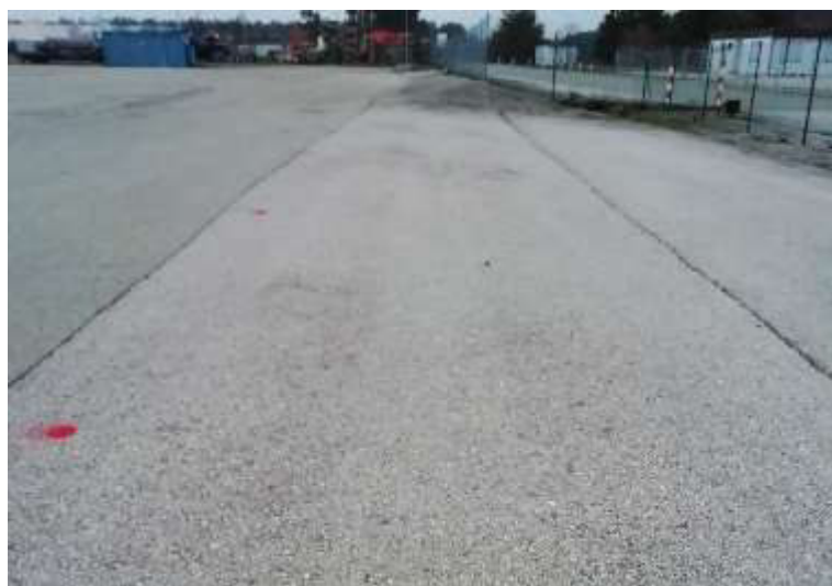
Abbildung 6: Nebenfläche mit Tragschichtmaterial
