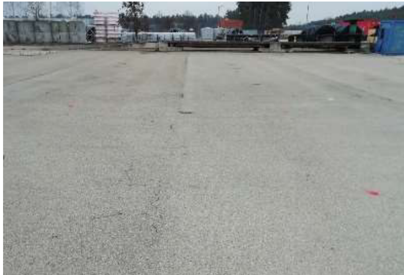
Abbildung 2: augenscheinlich homogene Asphaltfläche die den größten Teil der Grundstücksbefestigung einnimmt (Hauptfläche)
